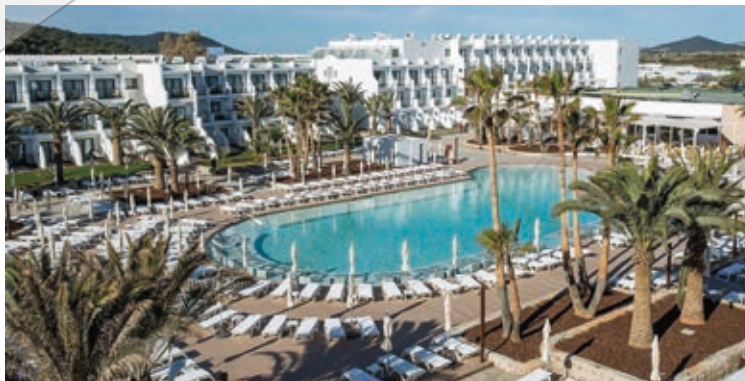
Instalação de 2 HP90W mod. 48 Hotel WHITE ISLAND RESORT (Ibiza)
